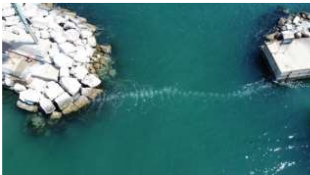
Figura 6 e 7 - Esempio di air bubble screen per il contenimento della torbidità
