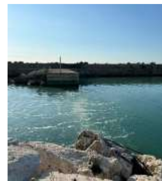
Figura 6 e 7 - Esempio di air bubble screen per il contenimento della torbidità
